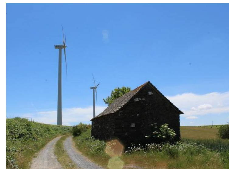
Poste de livraison existant
